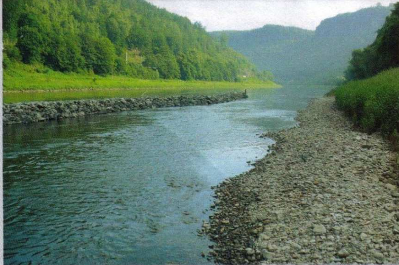
▲ Obr. 5. Břehy nad Dolním Žlebem po realizaci výhonů (zdroj: Pöry Environment, a.s.)
